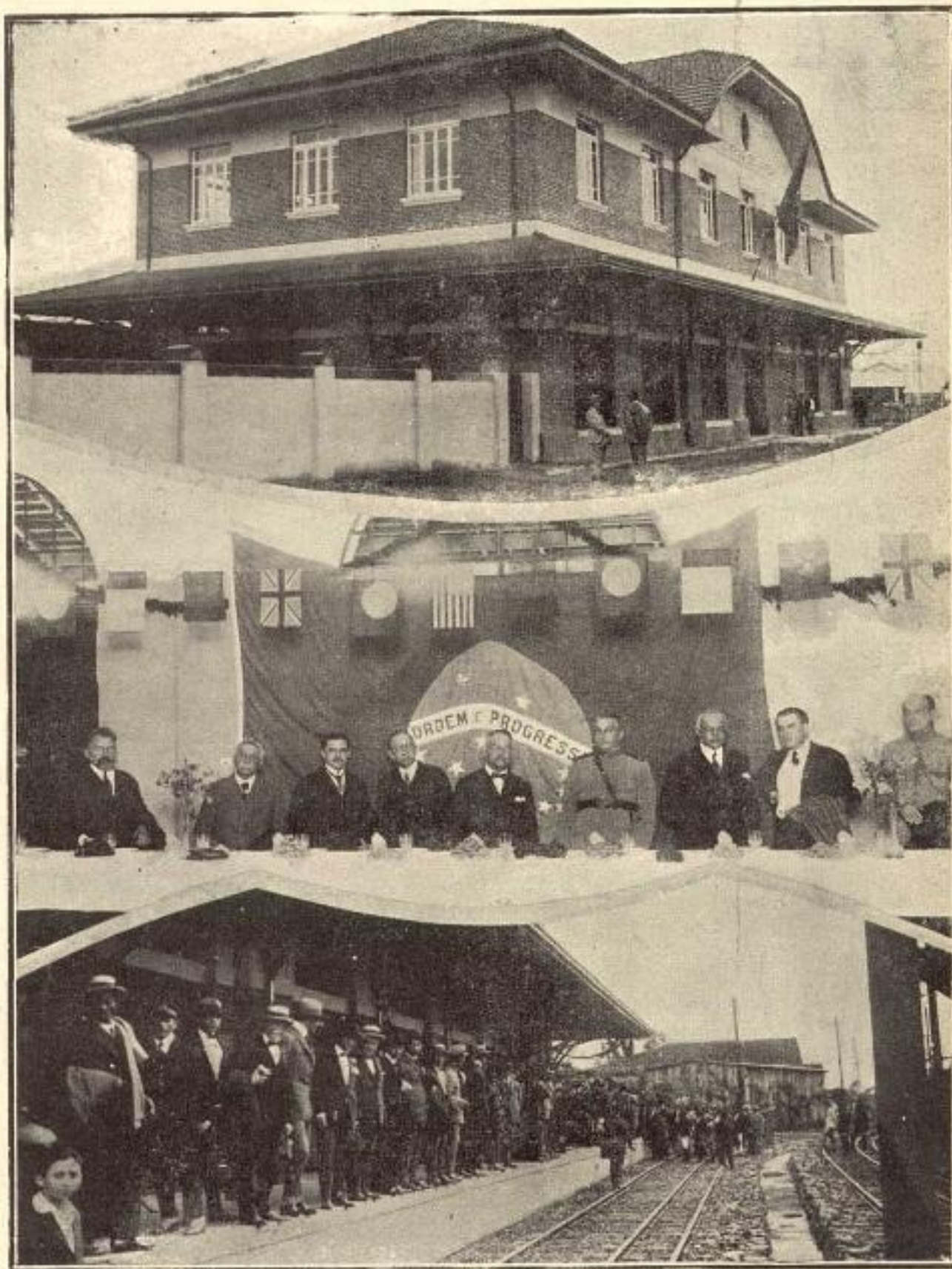
Photographias tiradas especialmente para "A Cigarra", a 20 de dezembro p. findo, quando da inauguração das obras de electrificação da Estrada de Ferro Campos do Jordão. Em cima, o amplo edifício da estação, em Piedamonhangaba; ao centro, aspecto da mesa de choro olato oferecida à míitica presidencial pelo dr. Mascarenhas Neves, director da Estrada; em baixo, aguardando os automotrices inauguraes.
