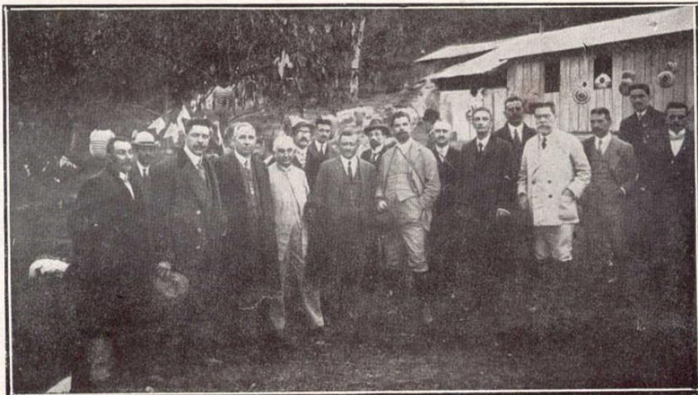
Visita da comissão de Fazenda da Camara dos Deputados ás obras da Estrada, percorrendo toda a linha
