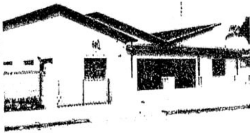
Fachada do Centro de Reabilitação
